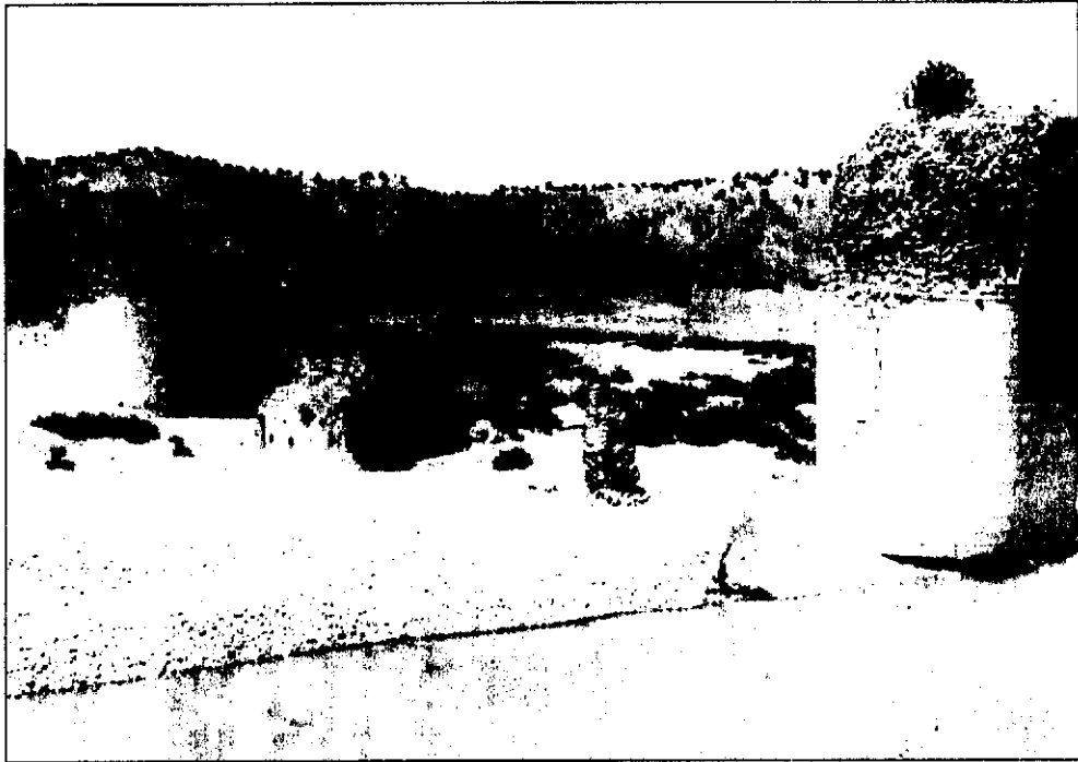
(شکل ۲۶). تصویری که در سال ۱۳۳۵/۶/۱۶ از پل کشکان گرفته شده است و بقایای پایه‌ای رانشان می‌دهد که اکنون به جز پیل قلوه سنگ آن اثری باقی نمانده است.
