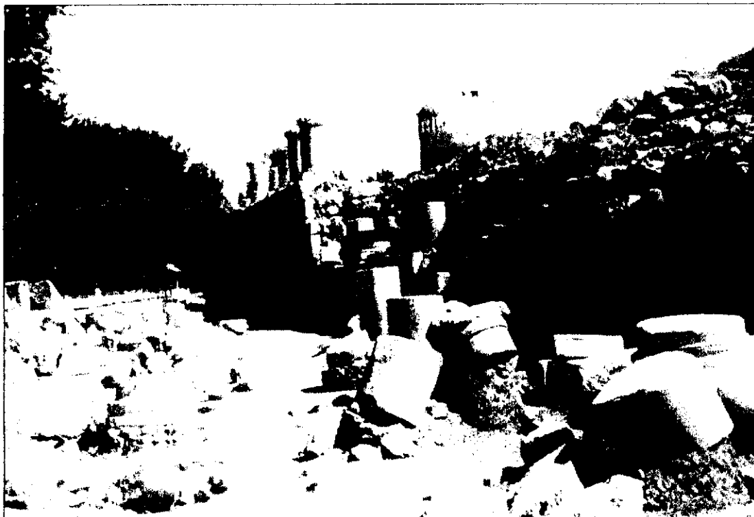
(تصویر-۵): جبهه غربی پس از زیاده کردن ستون ها و سنگ های نما و اجرای طرح بازسازی بخش های پیاده شده، در سال های ۱۳۶۴ و ۱۳۶۵.
