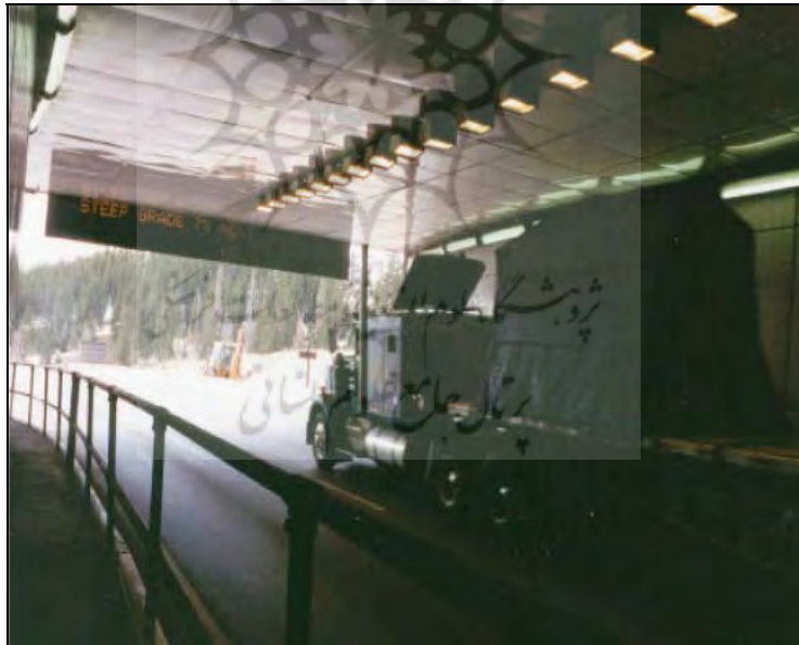
شکل چهار: تصویری از تابلوهای اطلاع‌رسان متغیر در داخل تونل [۳].
