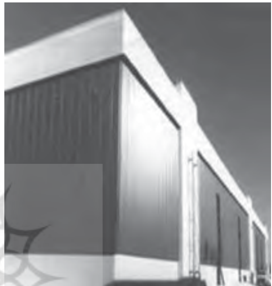
شکل ۵- بزرگترین سیستم گرمایش خورشیدی هوای تهویه جهان (w.TorontoFacilities)
