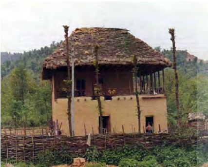
تصویر ۳- استفاده از پوشال برنج در سقف
