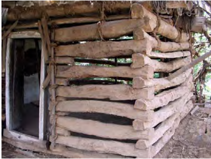
تصویر ۲- ساختن دیوار با استفاده از چوب
