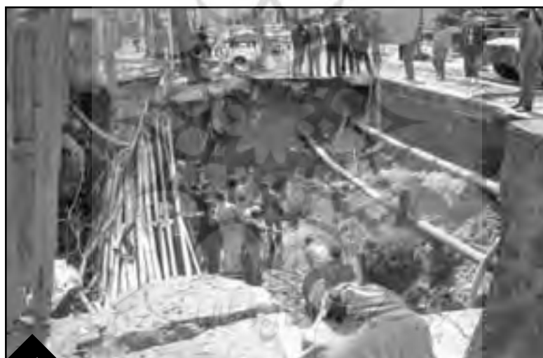
شکل شماره ۵- فروریزی بخشی از خیابان امام خمینی به عمق ۶ و مساحت ۲۰ مترمربع در اثر ترکیدن لوله آب (عکس الف) و فروریختن قسمتی از خیابان ولی عصر (طول ۲۰، عرض و عمق ۶ متر) مابین میدان ونک و پارک ساعی (عکس ب) که علت آن فروریزی بخشی از گالری کاریز متروکه در زیر خیابان بوده است
