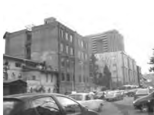
تصویر ۴- بدنه‌ی رها شده‌ی جنوبی خیابان.
