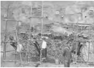
تصویر ۱۳- روش میخ کوبی - حفاری نیل ها. (مأخذ: نگارنده)
