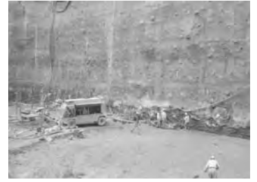
تصویر ۹- پایدارسازی جداره گودبرداری از خارج گود - روش میخ کوبی. (مأخذ: نگارنده)
