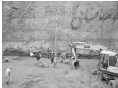
تصویر ۱۶- روش میخ کوبی - مشکلات اجرائی بالا بودن سطح آب زیر زمینی. (مأخذ: نگارنده)
