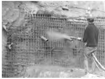
تصویر ۱۲- روش میخ کوبی - شاتکریت. (مأخذ: نگارنده)
