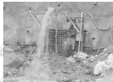
تصویر ۲۲- روش میخ کوبی - پمپاژ و زهکشی از چاه‌های دستی بستر گود. (مأخذ: نگارنده)
