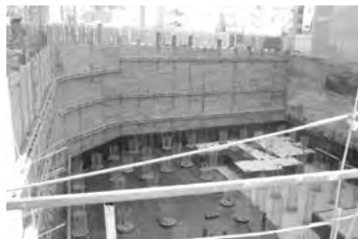
تصویر ۸- پایدار سازی جداره گودبرداری از خارج گود به روش شمع و انکراژ. (مأخذ: نگارنده)
