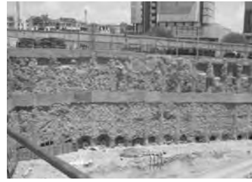
تصویر ۱۰- پایدارسازی جداره گودبرداری از خارج گود - روش تلفیقی (شمع افقی)، (مأخذ: نگارنده)
