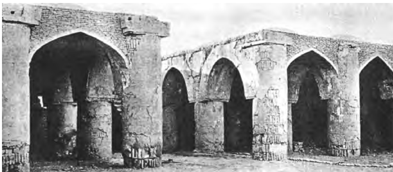
تصویر ۳ - استفاده از ستون‌های تویزه‌دار یکطرفه و بزرگ کردن میانوار جهت تاکید بر جهت قبله در مسجد تاریخانه دامغان. ماخذ: (پوپ، ۱۳۷۷)
